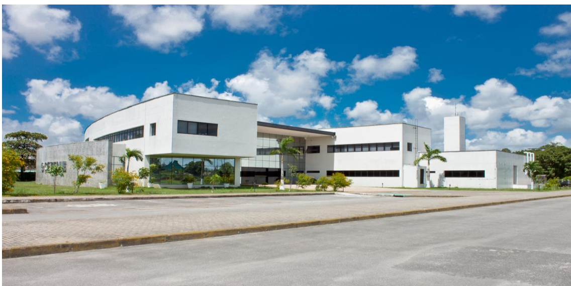
Figura 10: Fachada externa do CETENE. Fonte: foto fornecida pela atual coordenadora do laboratório.
