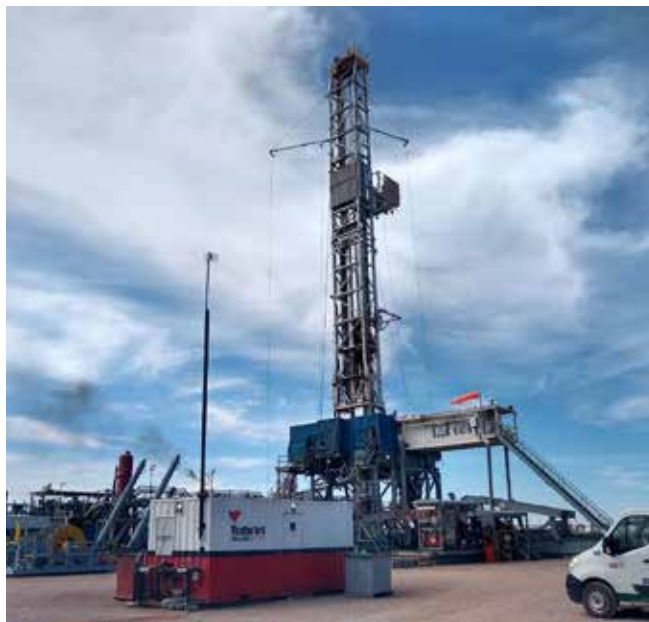
Figura 3: Atividade de perfuração de poço de shale gas em Neuquén (Argentina)
