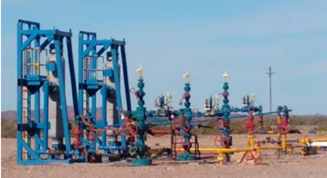
Figura 4: Poço de shale gas em Neuquén (Argentina)
