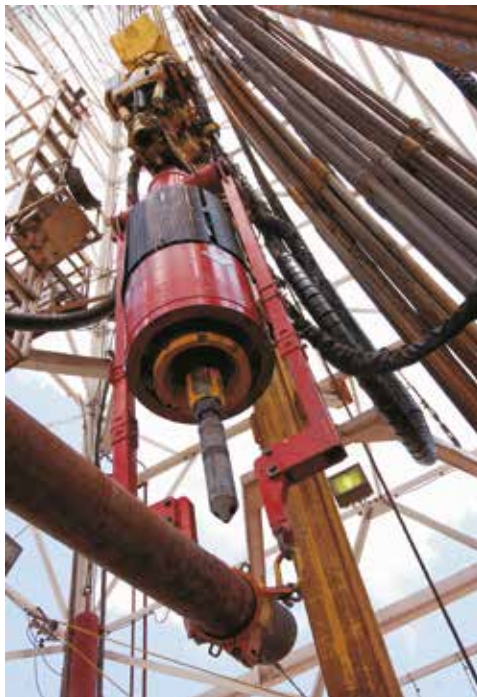
Figura 2: Atividade de perfuração
