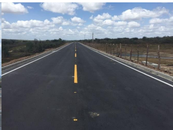
Trecho pavimentado da rodovia
