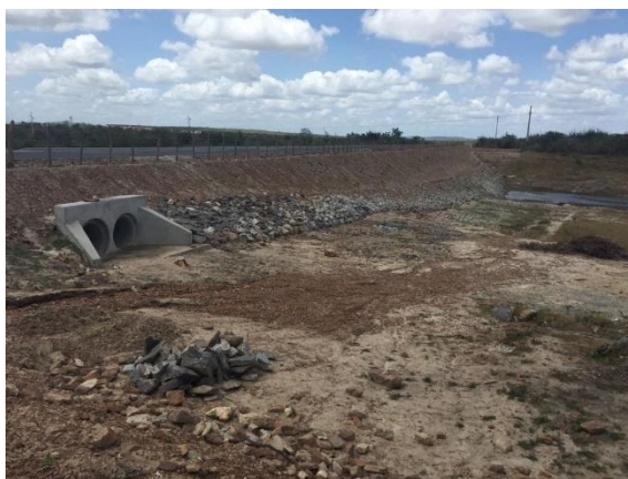
Rodovia com barramento do Açude Preto (recuperado)
