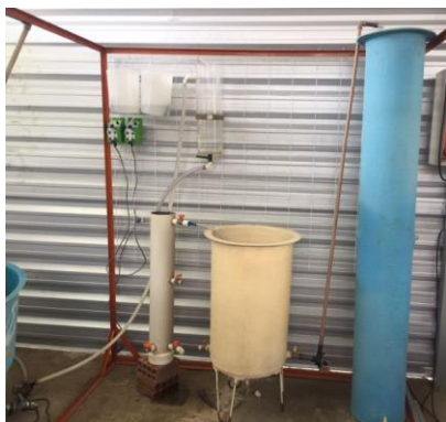
Unidade de floculação e decantação.
