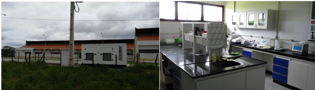
Grupo gerador para laboratórios
