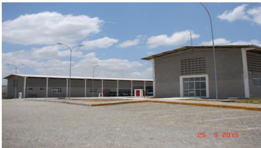
Vista externa dos blocos
