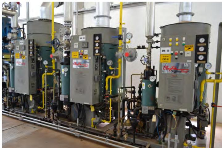
Figura 38 - Caldeiras para geração de vapor saturado
