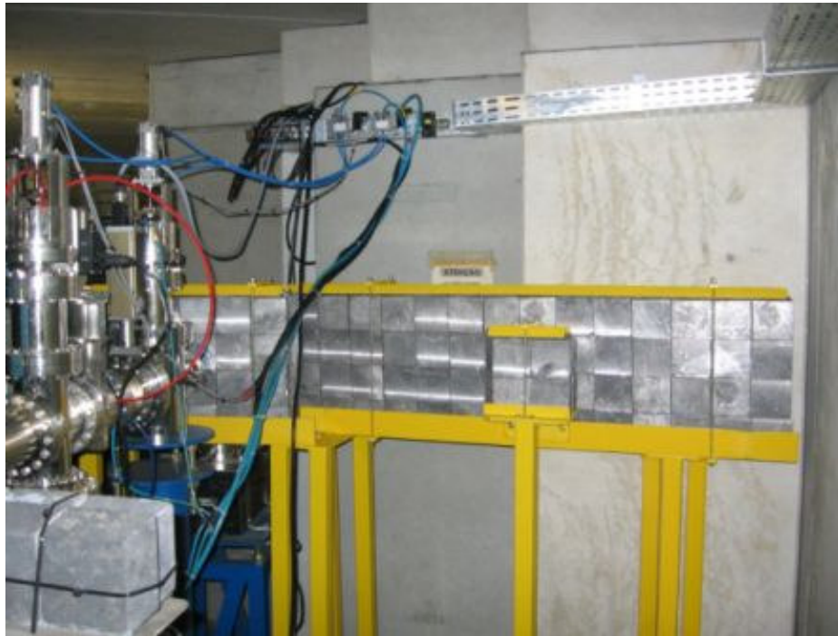
Figura 5: Vista de uma das paredes de chumbo instaladas nas saídas dos dipolos do anel de armazenamento.
