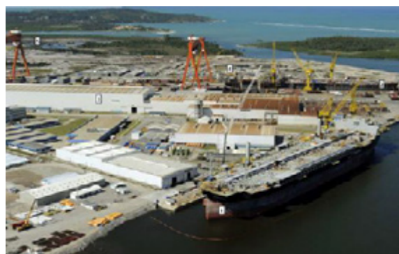
Figura 32 – Plataforma P-62 em construção no Estaleiro Atlântico Sul (agosto/2012).
