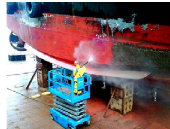
Figura 5 – Hidrojateamento em casco de embarcação.
