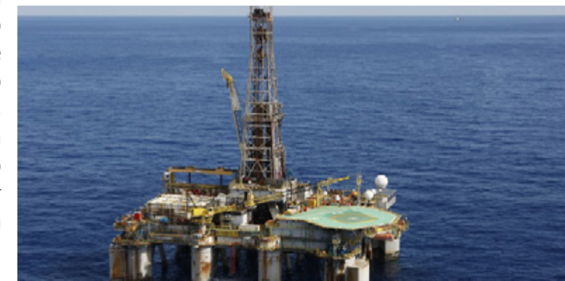
Figura 14 – Plataforma P-61 (TLWP) conectada à plataforma de apoio Tender Assisted Drilling (TAD) – Campo de Papa-Terra – Bacia de Campos.
