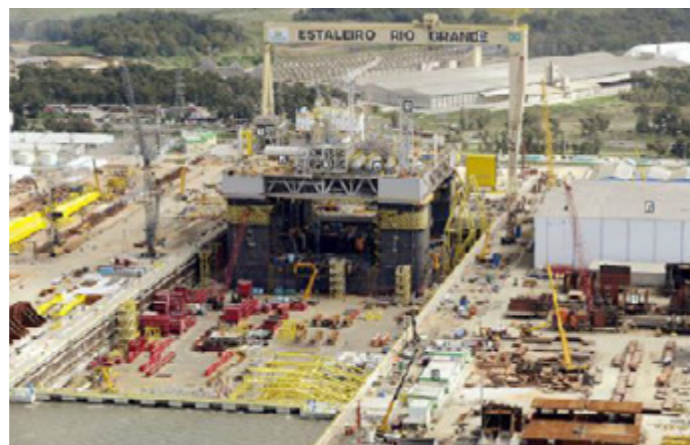
Figura 26 – Plataforma P-55 em construção no Estaleiro do Rio Grande (setembro/2012).
