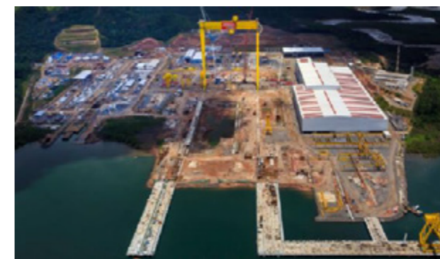
Figura 33 – Vista do Estaleiro Enseada Indústria Naval.
