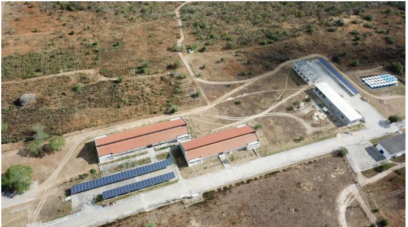
Geradores fotovoltaicos em forma de estacionamento de veículos, na Estação Experimental do INSA, onde também podem ser vistos os reservatórios do sistema de captação de água de chuva.
