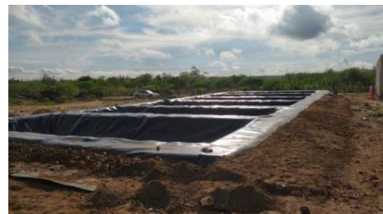
Etapas da construção das lagoas de estabilização
