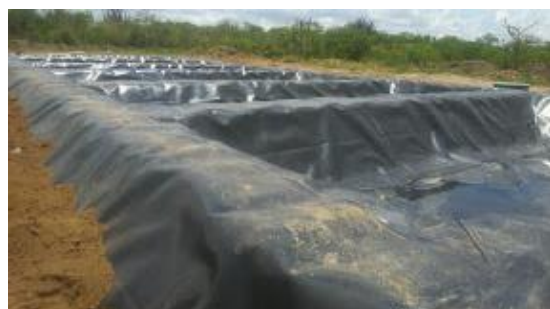
Etapas da construção das lagoas de estabilização
