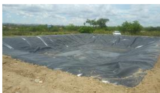
Reservatório para armazenamento e destinação do esgoto tratado.
