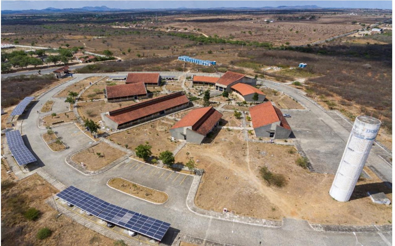
Geradores fotovoltaicos em forma de estacionamento de veículos, na Sede Administrativa do INSA, onde também podem ser vistos os reservatórios do sistema de captação de água de chuva e do sistema de tratamento de esgotos sanitários
