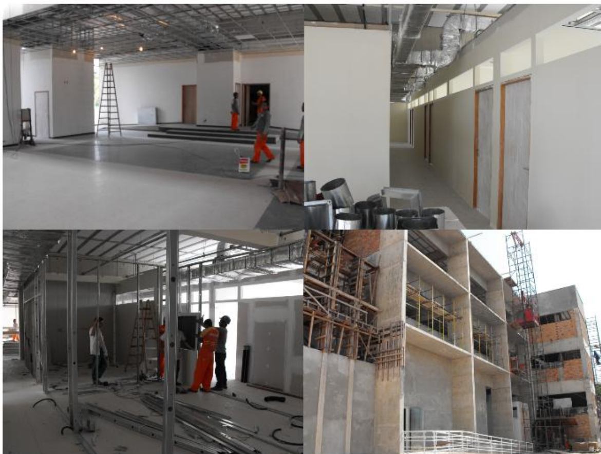
Fig. 3 - Prédio Sede do Centro Regional da Amazônia.
